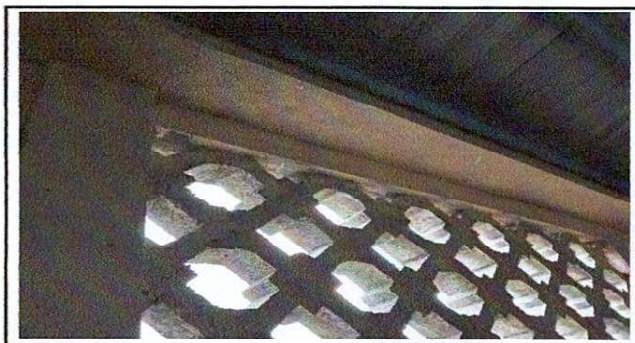
Foto 4: CANAL DE AGUA PLUVIAL SIN FILTRACION
